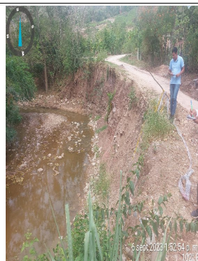
FOTOGRAFÍA N°01: TRAMO I. EROSION DE LA RIBERA DE LA QDA QUE AFECTA A CARRETERA
